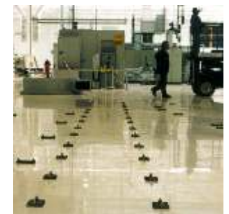
Aufriss- & Fundamentarbeiten
